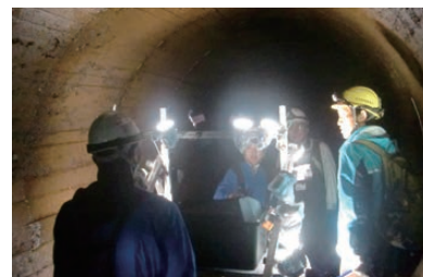
水路トンネルの保守
